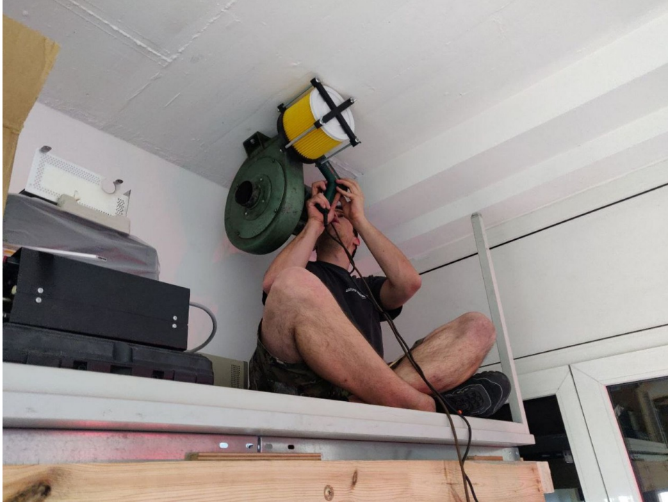
Abbildung 4: Montage des Raumluftfilters
