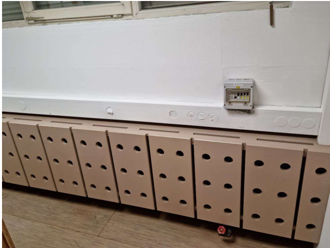
Figure 4: Neue Räume vorher
